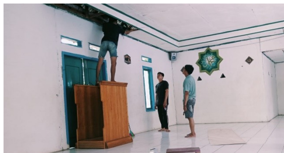
Gambar Proses Perbaikan
